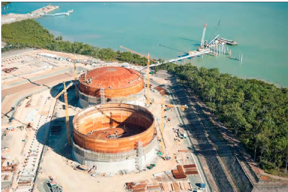
LNG tanks and Jetty
